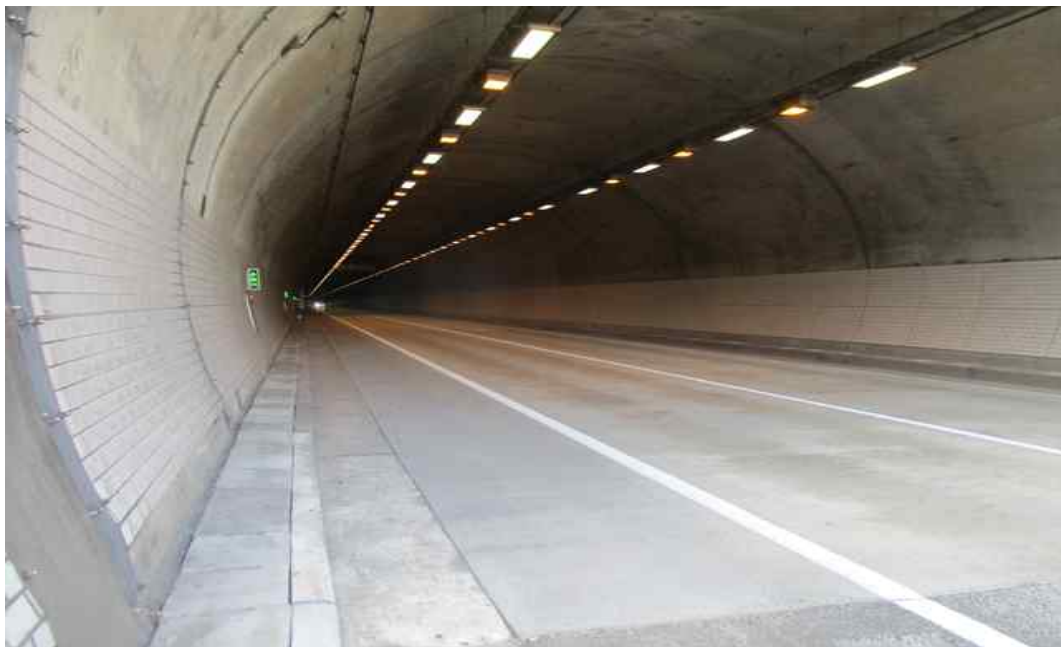
군자2터널(양양) 내부 전경
